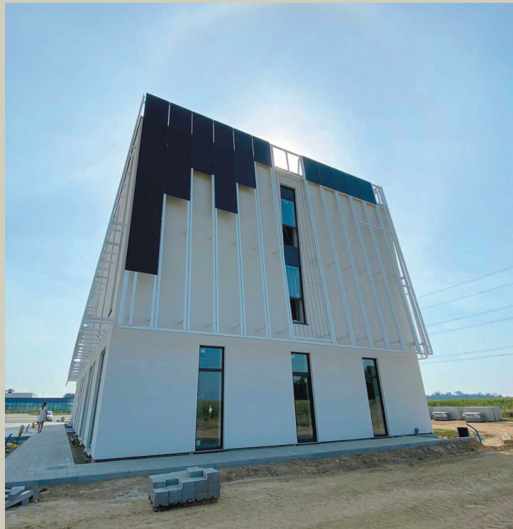
Montaż paneli ozdobnych
